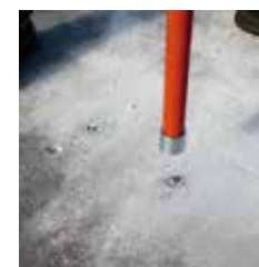
ボルト切断後の 突起残を叩ける、 ハンマーヘッド付
