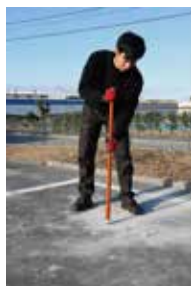
出っ張っている 寸切りボルトに ポキポキBOLTをセット して
