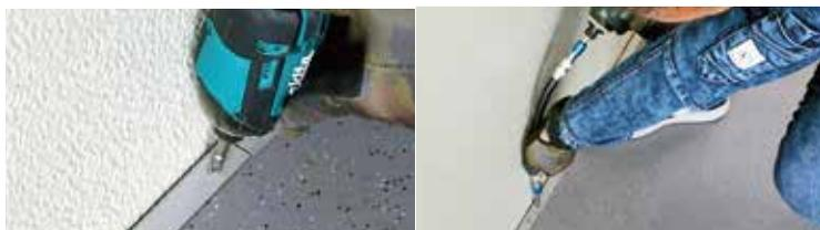
壁際のビス締めは、インパクトドライバにビットを付けて行くと、インパクトドライバのボディが壁に当たってしまうとうまくビス締めできません。
