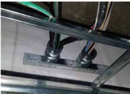
電線管ブラケット取付け
