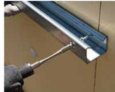
壁面ビス締め固定
