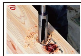
②アンカー後施工用ドリルでネジ山にかかる程度、穴をあける
