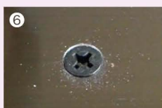
抜き穴に再度ビス打ちをする。
