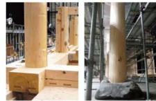
樹齢300年のヒノキ(寸法520mm・長さ5メートル)柱8本に、当社で材の中心に90mmの貫通穴(芯抜き)を行う。
