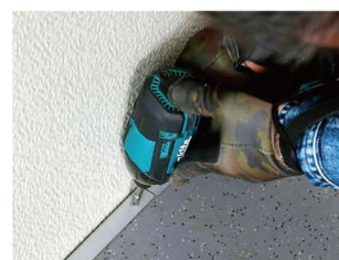
インパクトドライバの頭が邪魔で 作業がしにくい
