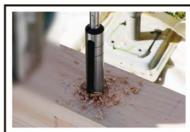
④アンカーボルトの周囲を穴あける。
