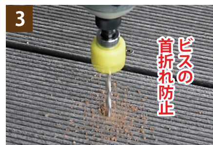
ウッドデッキ材に対応したウッドデッキ用皿取錐で下穴をあける
