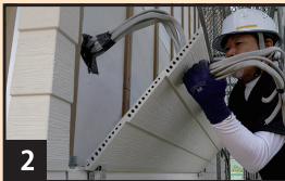
2 サイディングを仮置きし壁側からの配線を通す。
