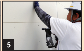
5 綺麗にはめ込み、もう片方を釘打ちする。
