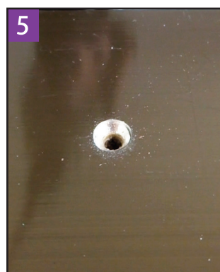
ネジ頭がつぶれたビスを抜き取った後
