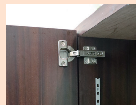
側面もネジ締めを行い金具を固定する。
