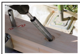
③基礎に土台をのせたままアンカーボルトにドリル先端を被せる。
