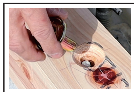
①座金がアンカーボルトのネジ山にかからない。
