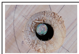
②アンカーボルトが斜めに立ち上がり土台の通りを修正することができない。
