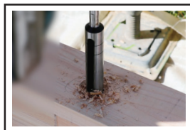
④アンカーボルトの周りを穴あける。
