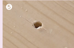
抜き穴も損傷が少ない。
