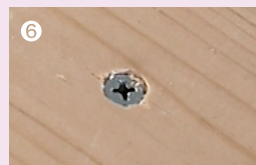
抜き穴に再度ビス打ちをする。
