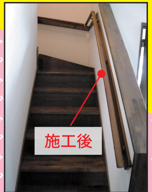
リフォーム階段手摺り施工
